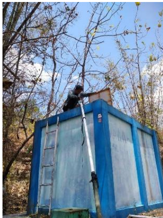
Gambar 2 Observasi ketersediaan air bersih di bak penampungan air
